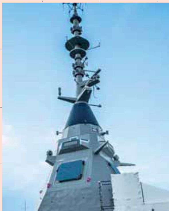
HAUT DE 50 MÈTRES, PESANT 140 TONNES, LE PANORAMIC SENSORS AND INTELLIGENCE MODULE (PSIM) HÉBERGE SOUS LA FORME D'UNE MÂTURE UNIQUE UNE GRANDE PARTIE DU SYSTÈME DE COMBAT DE LA FDI.
